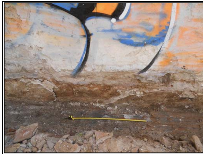
Foto 3. Detall del mur que delimita el solar amb el carrer arc de Sant Cristòfol. Es veu l'enlluït i el mur de carreus.
