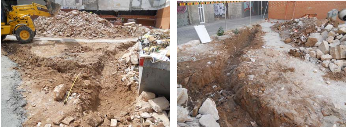
Foto 8 i 9. Rases per la instal·lació de l'enllumenat a la banda del carrer arc de Sant Cristòfol i carrer Mestres Casals i Martorell respectivament.
