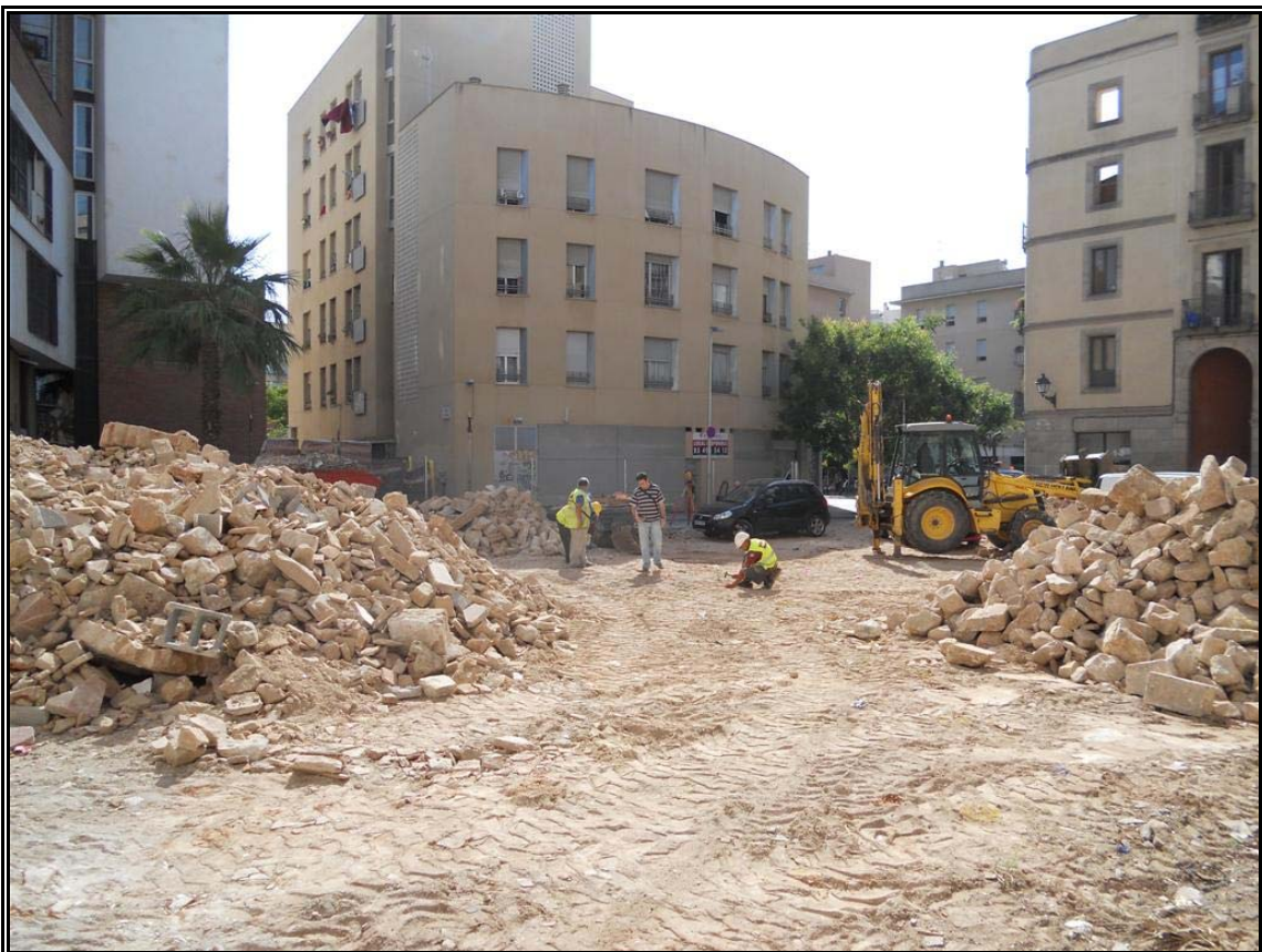
Foto. 1. Vista del solar en el moment d'iniciar la intervenció.
