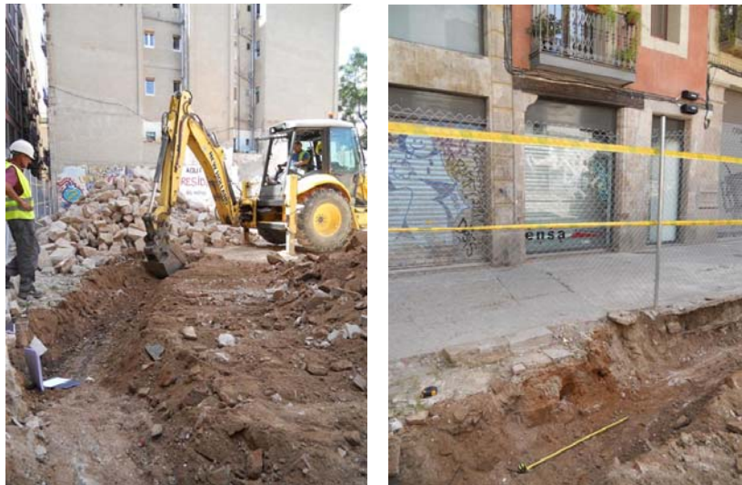
Foto 6 i 7. Obertura de la segona rasa a toca del carrer Mestres Casals i Martorell. A la segona foto s'observen restes dels murs de façana dels edificis recentment enderrocats.
