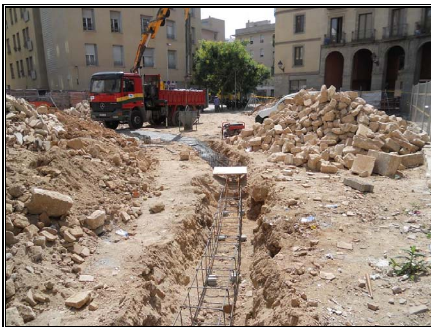
Foto 5. La primera rasa des del carrer Mestres Casals i Martorell parcialment farcida de formigó.
